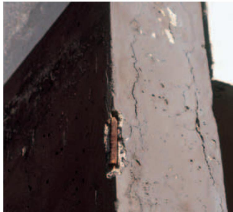
Процесс ржавления металлической арматуры в бетоне приводит к его растрескиванию
