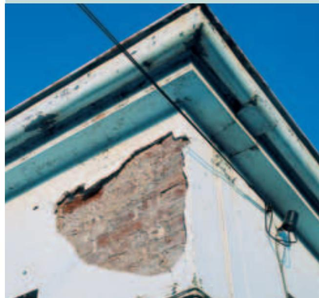
Влажность воздуха и заморозки приводят порой к разрушению оштукатуренных поверхностей
